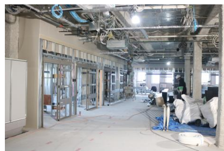
▲2階回復期リハ病棟。東側廊下。
