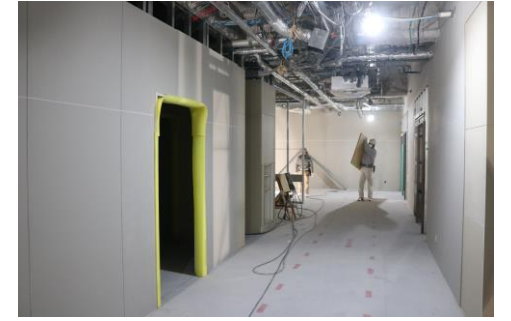
▲1階廊下。西から東側を望む。
