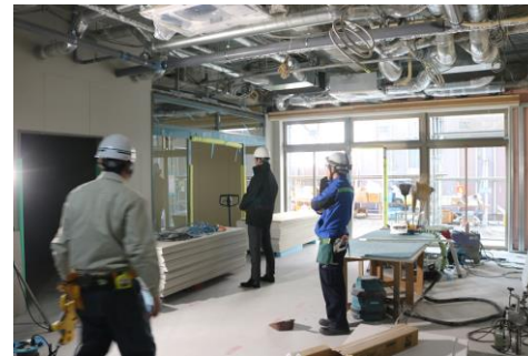
▲1階・玄関ホール付近
