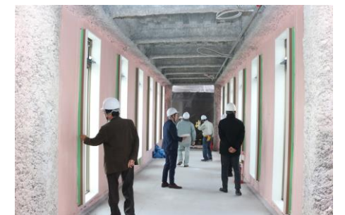
▲市道上の空中通路の内部。壁と窓枠がつけました。
